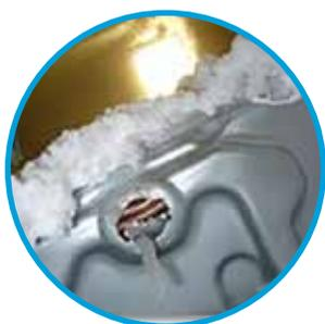
Passagem de fluido frigorígeno no tabuleiro de condensados e no permutador de calor
